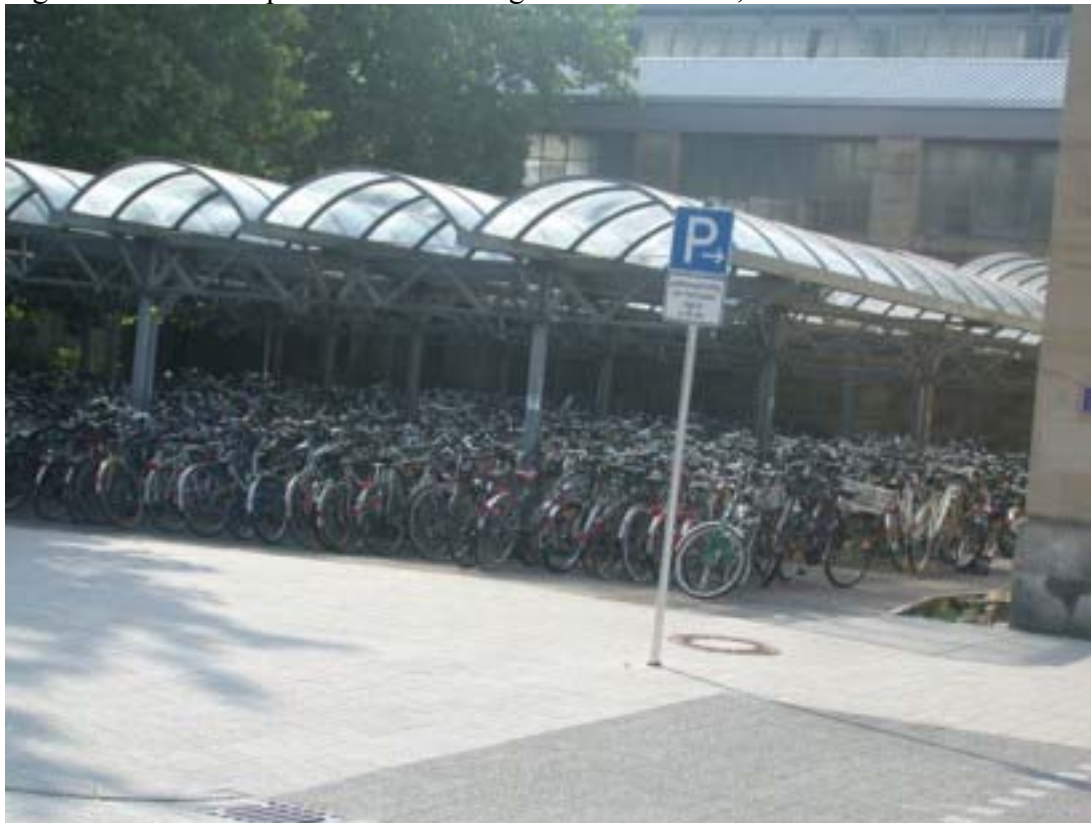
Figure 13. L'un des parcs à vélos de la gare de Karlsruhe, côté tram-train.
