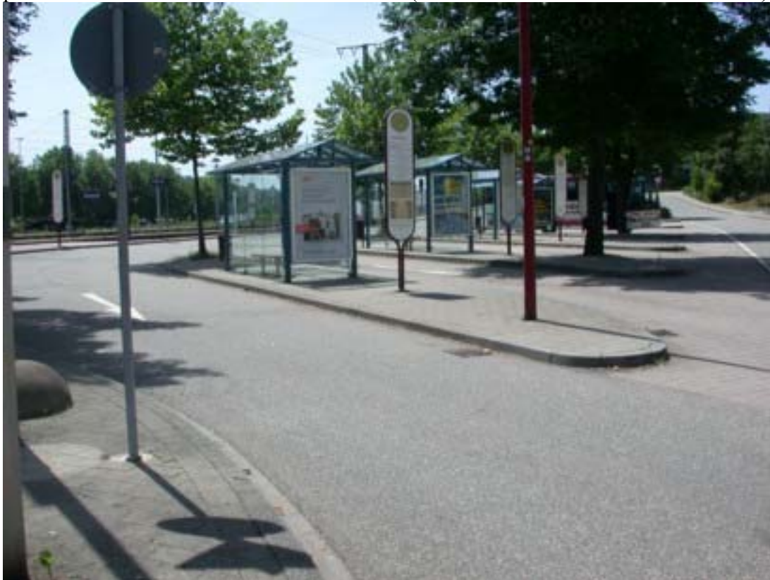
Figure 5. Intermodalité tram-train / bus à la gare de Bretten : plusieurs quais parallèles à proximité immédiate des voies de tram-train (on voit un bus au fond derrière l'arbre).
