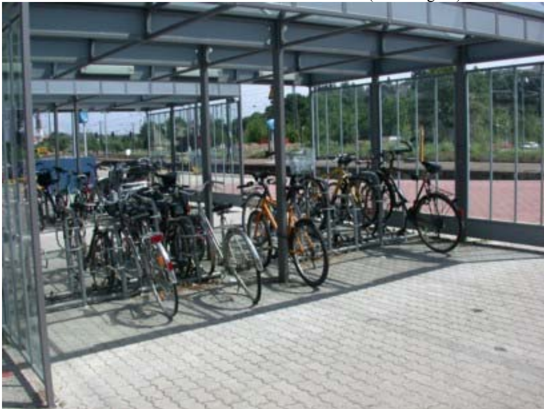
Figure 4. Exemple de stationnement de vélos sous abri couvert, à proximité immédiate des voies du tram-train. Au fond en bleu derrière l'abri : box (ou consignes) à vélos.
